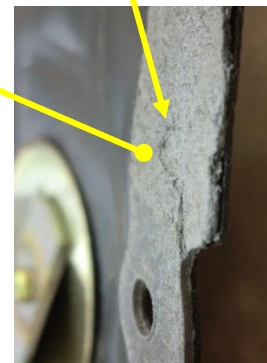
ガスケット欠損
